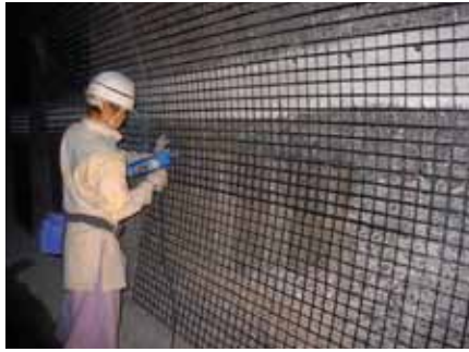
②-AGグリッド設置
