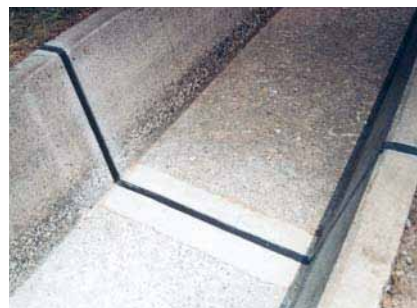
⑥ 仕上げ完了
