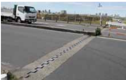
平成25年(2013)時点 平成4年(1992)施工後、21年経過。 環状7号(東京)に架かる橋梁 【24時間交通量:約60,000台】
