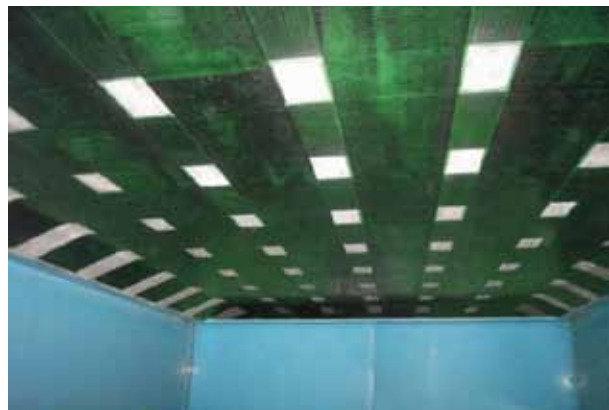
カーボン繊維クロス<br/>の接着完了
