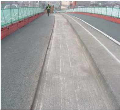
③・④床版コンクリート切削/研掃完了
