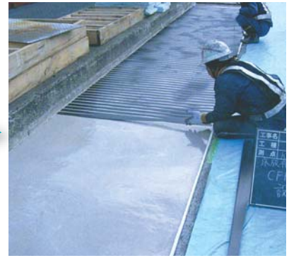
⑥CFプレート設置
