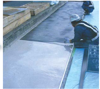
⑥CFプレート設置
