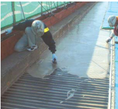
⑦ショーボンド JH-3敷設(上層)
