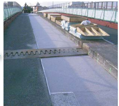
⑨補強完了
