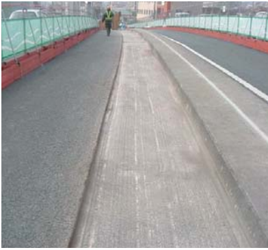
③・④床版コンクリート切削/研掃完了
