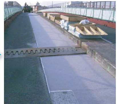
⑨補強完了
