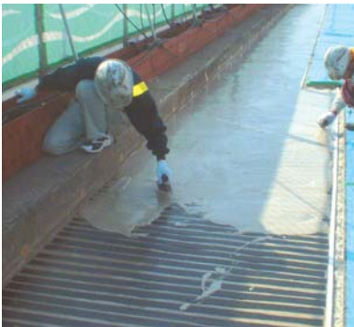
⑦ショーボンド JH-3敷設(上層)
