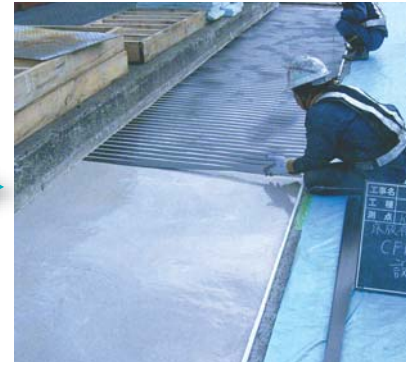
⑥CFプレート設置
