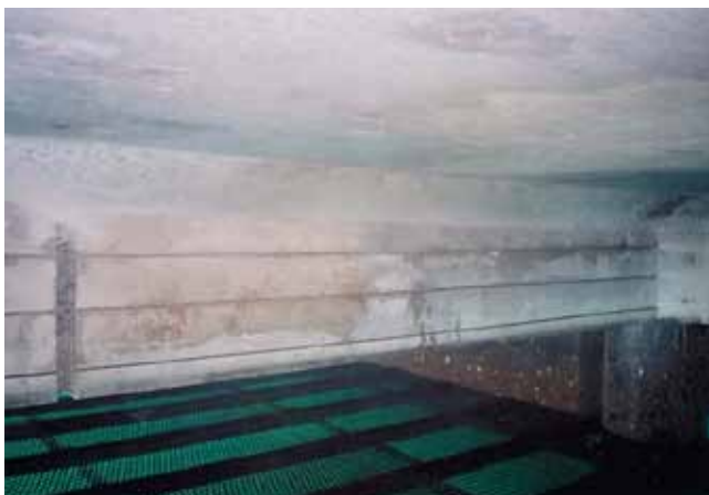
②カッター工完了
