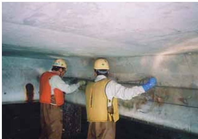
④モルタルおよび電極設置
