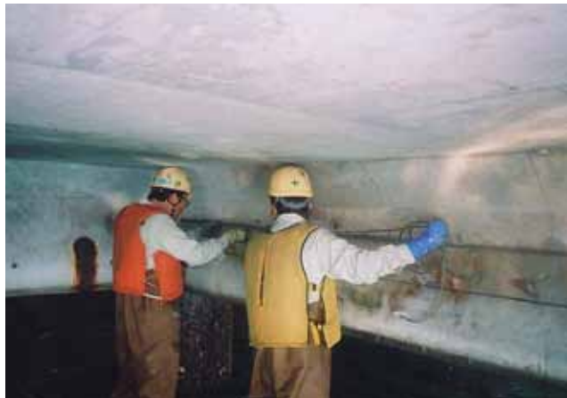
④モルタルおよび電極設置
