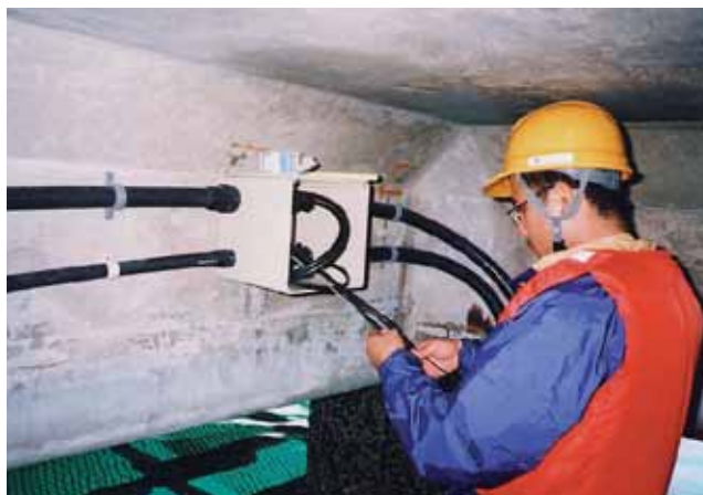
⑤ケーブル配線／ボックス取付
