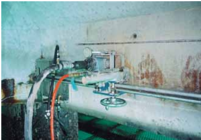
①カッター設置状況
