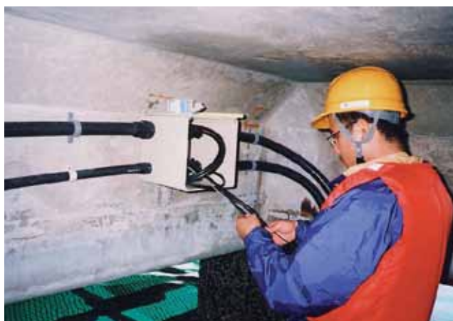
⑤ケーブル配線／ボックス取付
