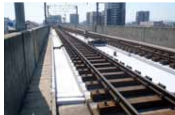
◀鉄道橋上部工の防水対策
