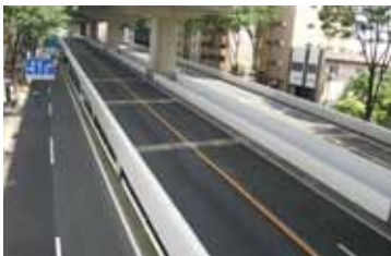
◀道路橋壁高欄の水掛かり防止対策
