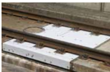
◀軌道スラブの水掛かり防止対策
