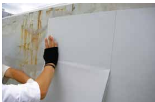
②シートの貼付け
