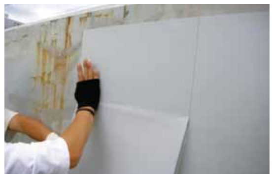
②シートの貼付け
