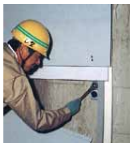
▲取付け金具の設置
