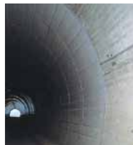
▲完成(設置端部)
