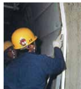
▲SIボード設置
