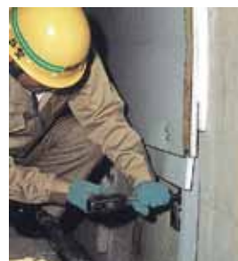
▲アンカー打込み
