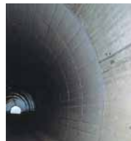
▲完成(設置端部)
