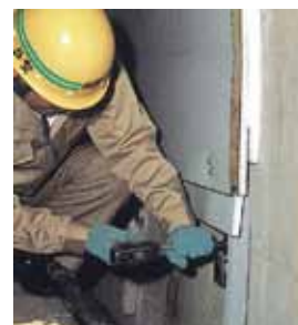
▲アンカー打込み
