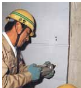
▲テクスボルトの打込み
