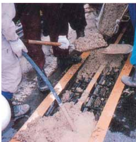
⑤コンクリート打設
