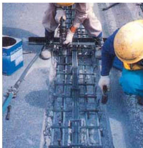
②圧縮セット、コンクリートアンカーの打込み
