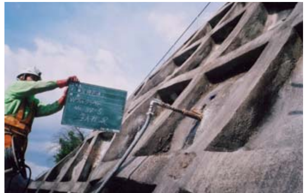
▲吹付けのり枠
