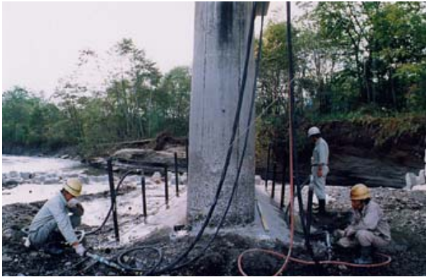
▲橋脚フーチング下部
