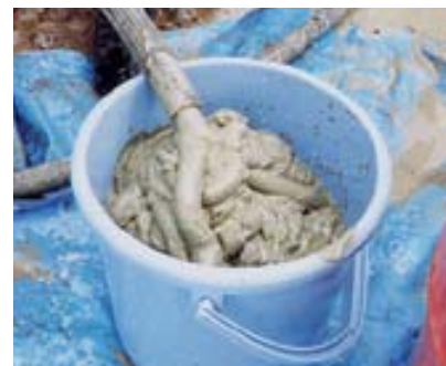
▲A液とB液を混合し、可塑状モルタルとなったWフィルグラウト
