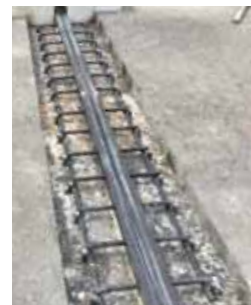
▲ 伸縮装置設置完了
