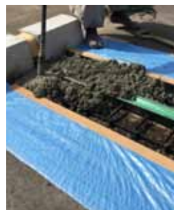
▲ 裏込め材打設
