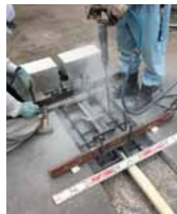
▲ コンクリートアンカー設置
