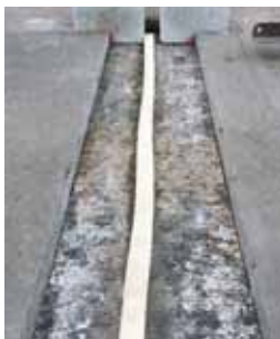
▲ 既設伸縮装置撤去
