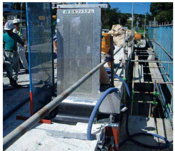
実橋における切断作業
