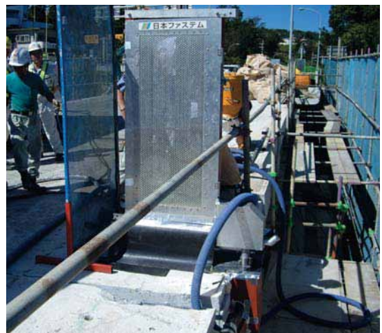
実橋における切断作業
