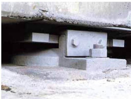
▲金属溶射完了
