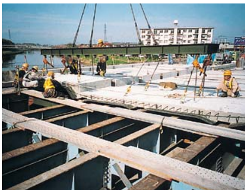
③スーパー床版の架設
