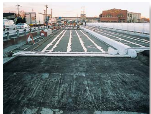
⑤橋面防水
