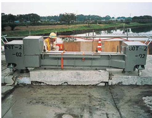
②既設床版の解体・撤去
