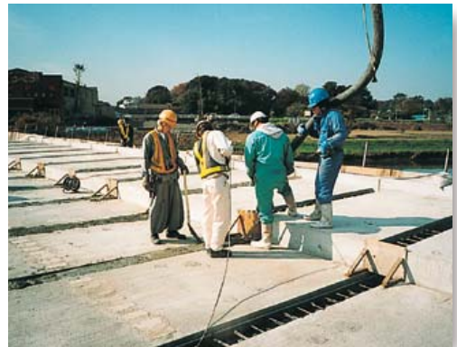
④継手部の配筋・打設
