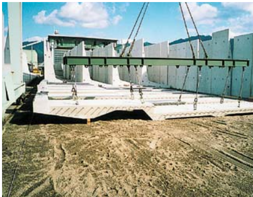
①スーパー床版製作
