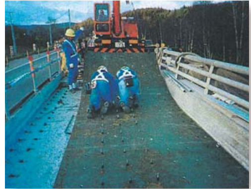
④上面鋼板取付け
