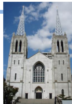
2014年10月撮影(施工後29年経過)
