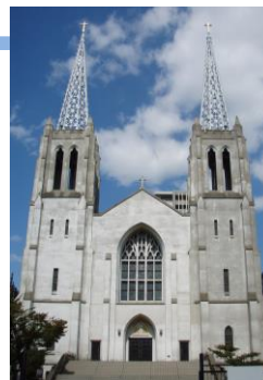
2014年10月撮影(施工後29年経過)
