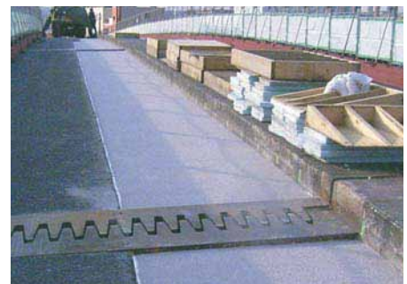
珪砂散布後の補強完了状況
