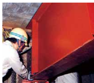
縦げた取付工
