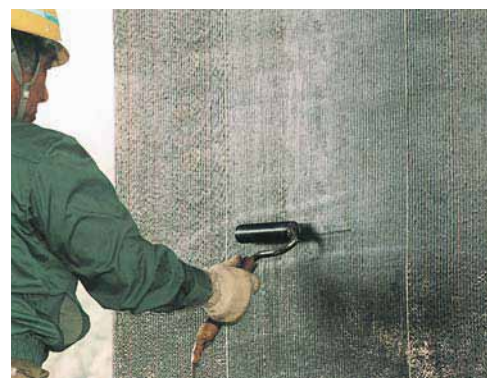
アイロンローラーによる樹脂含浸施工状況 (アイロンを使用した樹脂含浸方法は、弊社の特許です。)
