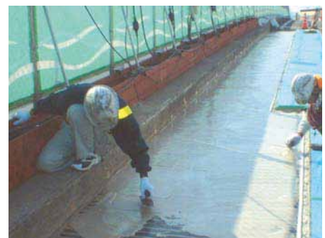
上層樹脂モルタルの敷設
