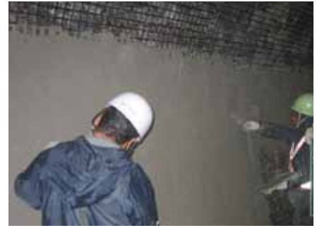
④-AGモルタルによる表面被覆
