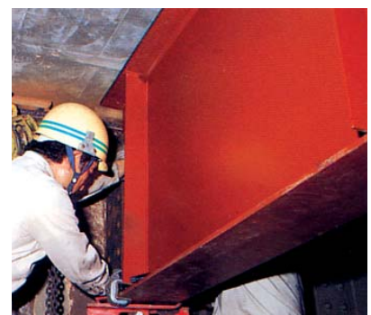
縦げた取付工
