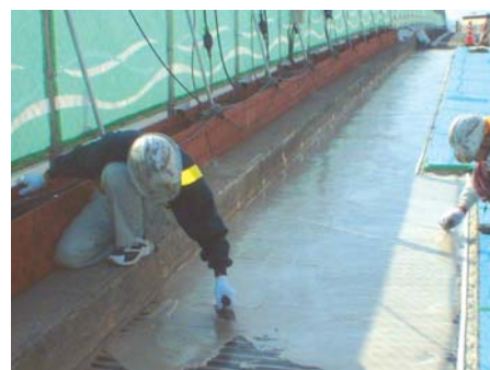
上層樹脂モルタルの敷設
