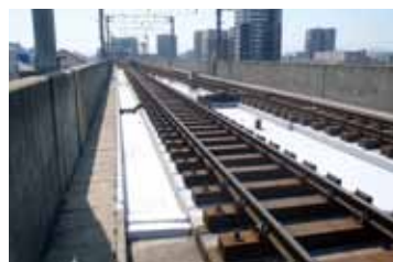
◀鉄道橋上部工の防水対策
