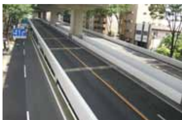
◀道路橋壁高欄の水掛かり防止対策
