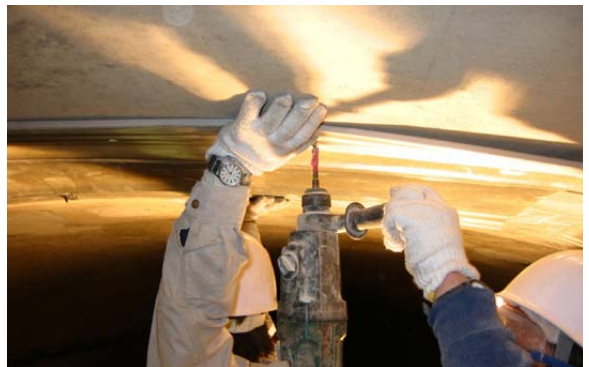
3.アンカー削孔
