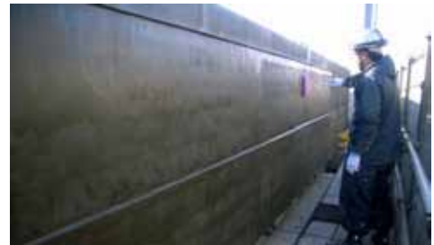
▲ プライマー塗布
