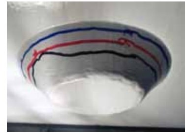
押し抜き試験
