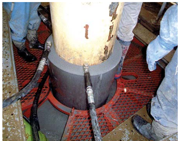
無収縮モルタル充填状況
