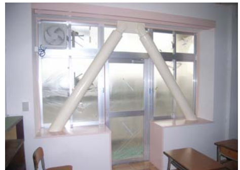
完 成(出入口開口付)
