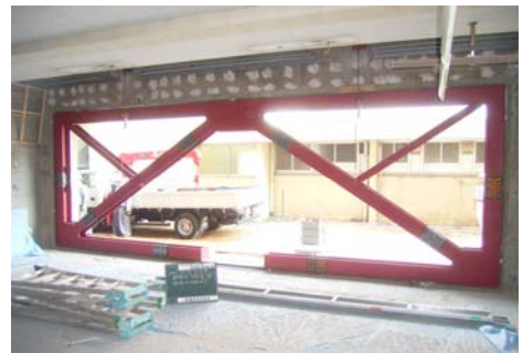
鉄骨建方完了
