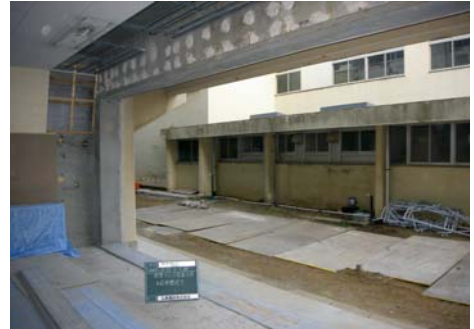
下地調整完了
