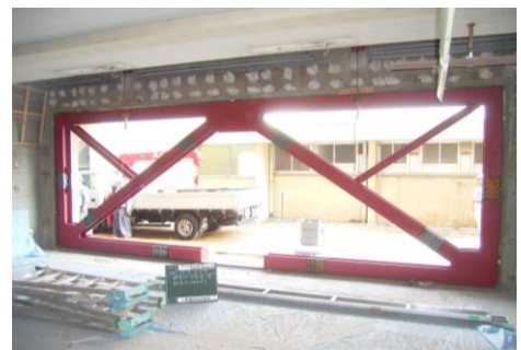
鉄骨建方完了
