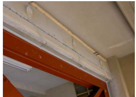
注入樹脂のオーバーフロー状況
