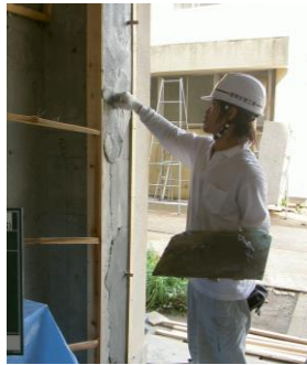
下地調整状況
