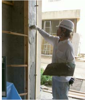
下地調整状況
