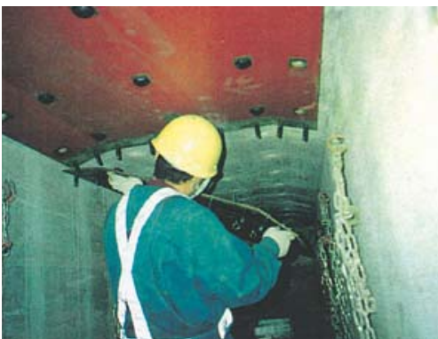
③下部鋼板取付け
