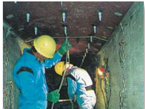
⑤グラウト注入状況
