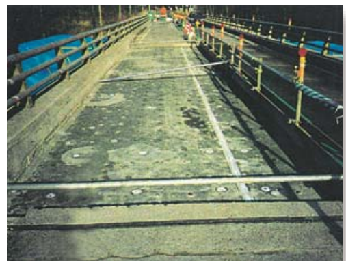
⑥注入工完了
