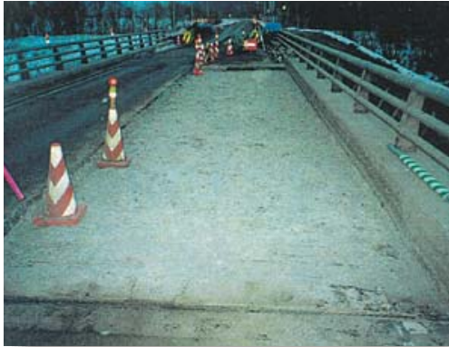
①床版上面舗装撤去完了(半車線施工)
