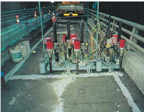
②通しボルト部 コア穿孔
