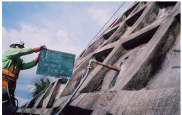
吹付けのり枠
