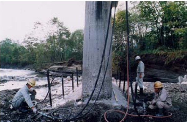
橋脚フーチング下部
