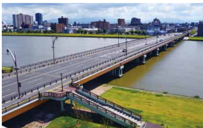
◎ひび割れ注入後50年経過した昭和大桥 【2014年9月2日撮影】
