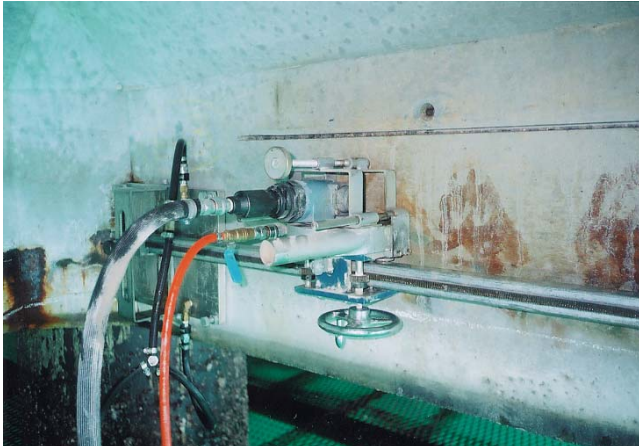
①カッター設置状況
