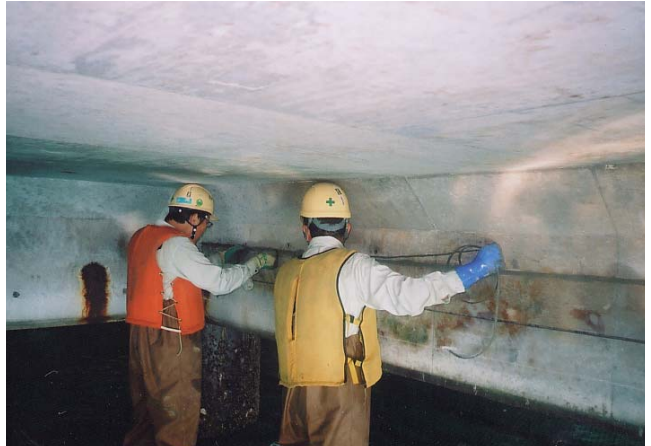
④モルタルおよび電極設置
