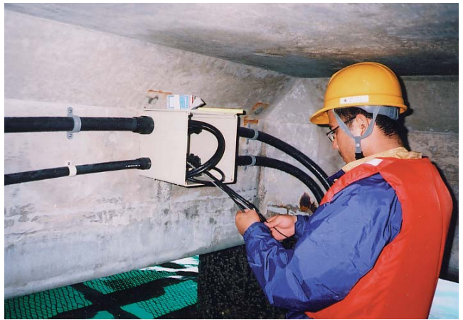
⑤ケーブル配線 / ボックス取付
