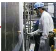
プライマー塗布
