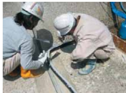
④ 特殊エポキシ樹脂塗布
