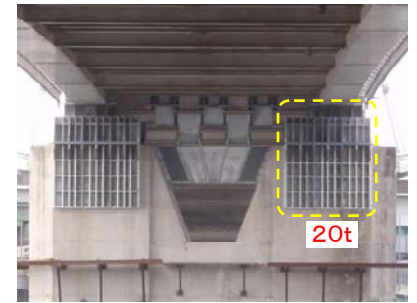
写真-6 住吉浜大橋 (変位制限構造)
