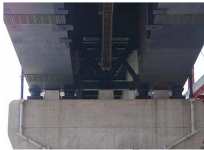
写真-2 第2摩耶大橋 (段差防止構造)
