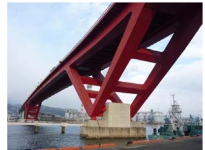
写真-3 灘浜大橋 (支承固定構造)
