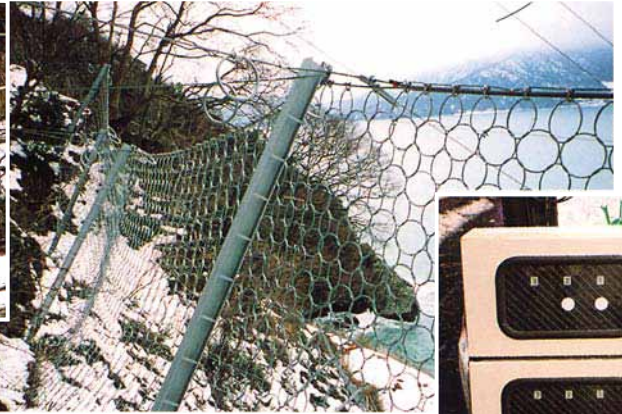
⑦ 奇岩対策工
