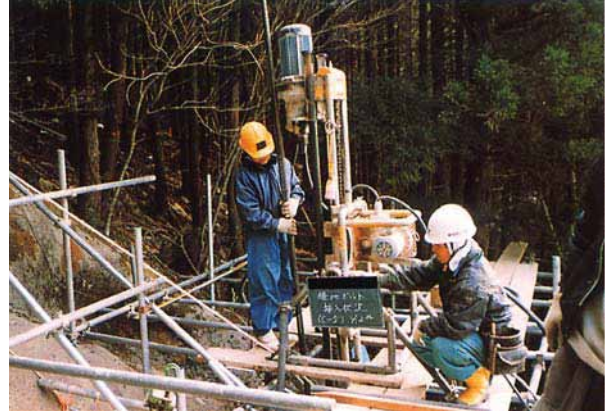
⑥ 斜面对策工 (縫地工法)
