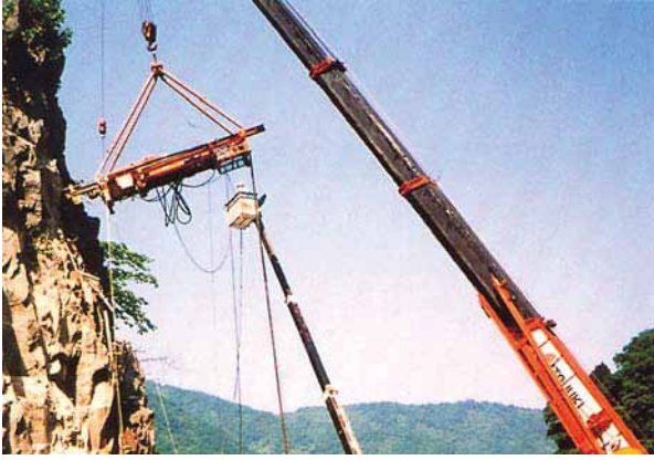
④ 岩盤補強 (ロックボルト)
