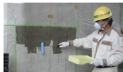
塗布・含浸作業
