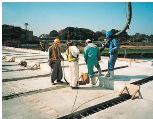
④継手部の配筋・打設
