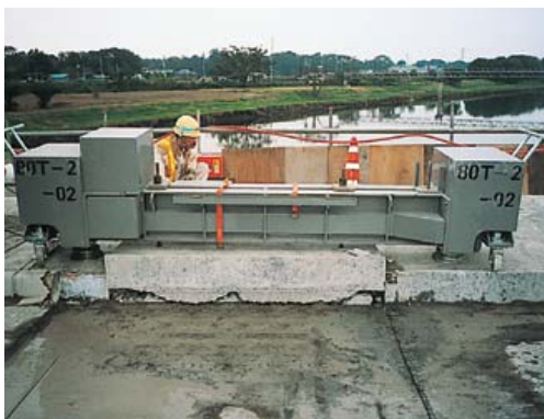
②既設床版の解体・撤去
