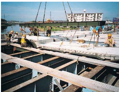
③スーパー床版の架設
