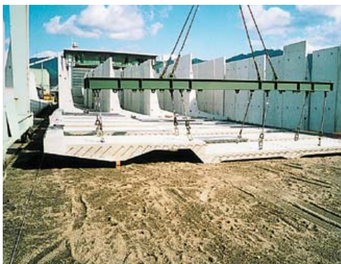
①スーパー床版製作
