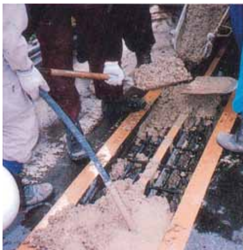
⑤コンクリート打設
