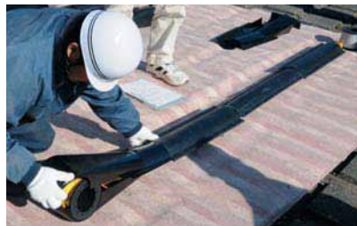
*保護カバー：ポリプロピレン製
